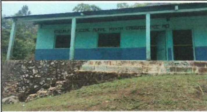
Foto 1: Sustitucion de pintura de aceite en su interior y exterior y sustitucion de puertas,ventanas por metal
