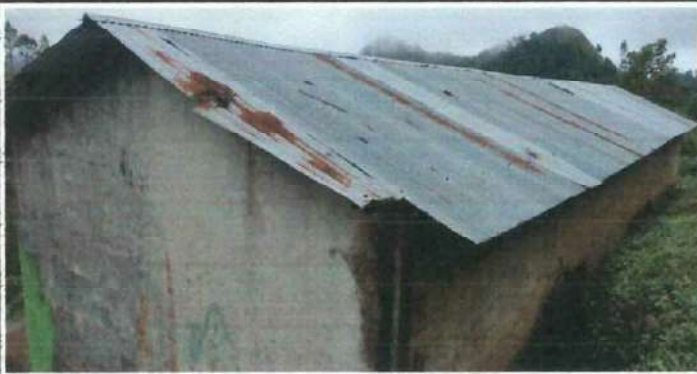
Foto 3: Sustitucion de laminas del techo en mal estado
