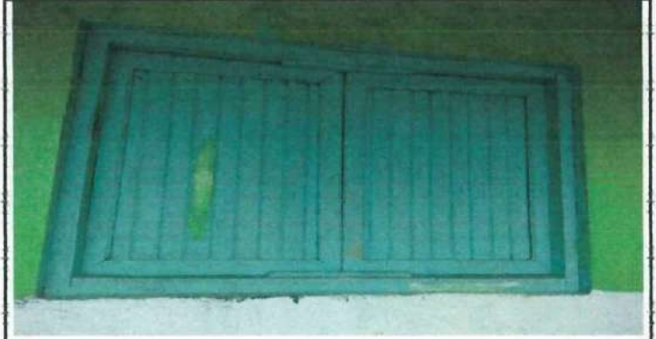
Foto 4: Sustitucion ventanas de madera a metal.
