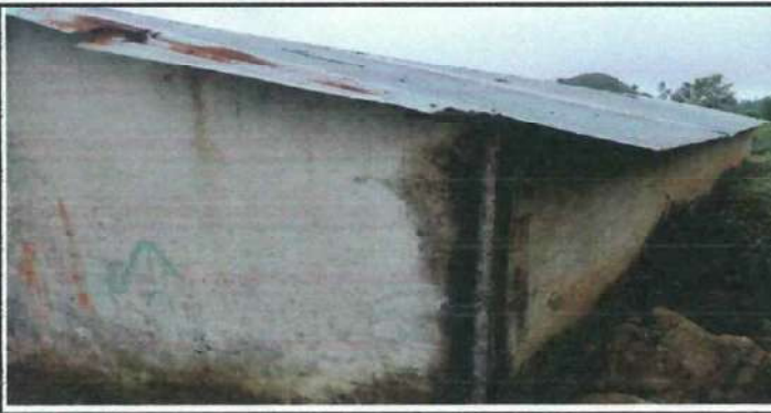
Foto 5: Mantenimiento repello en paredes parte lateral
